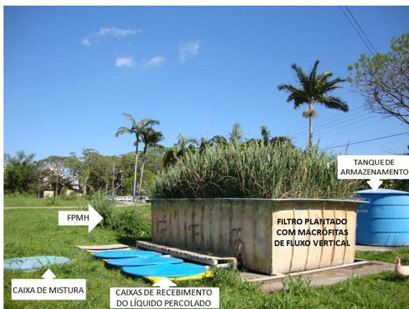
**Figura 1.** Fotografia do sistema de tratamento de lodo de tanque séptico. Fonte: arquivo pessoal.
